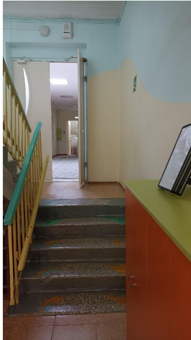
Фото № 2 Лестница (внутри здания)
