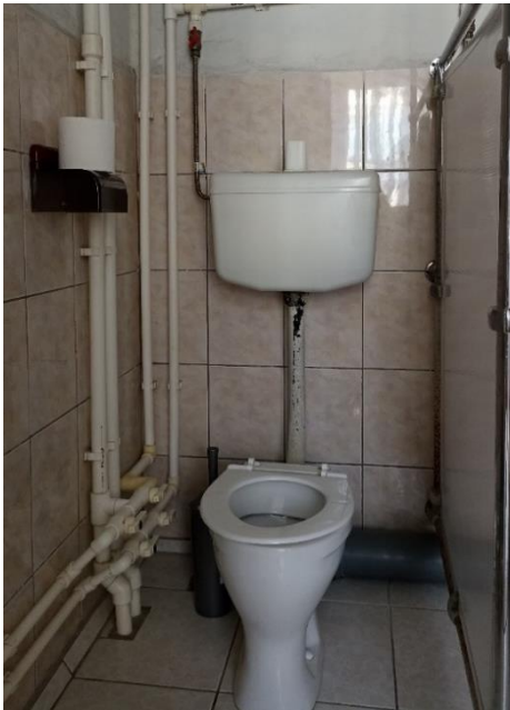
Фото № 1. Туалетная комната
