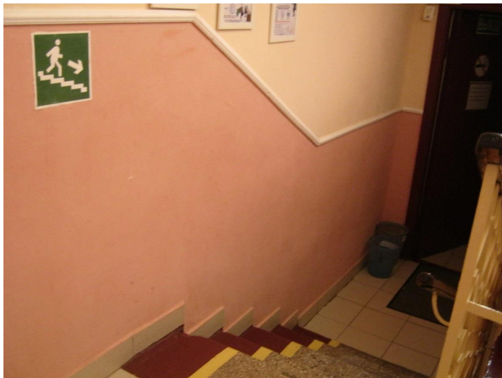
Фото № 5 Пути эвакуации (в т.ч. зоны безопасности)
