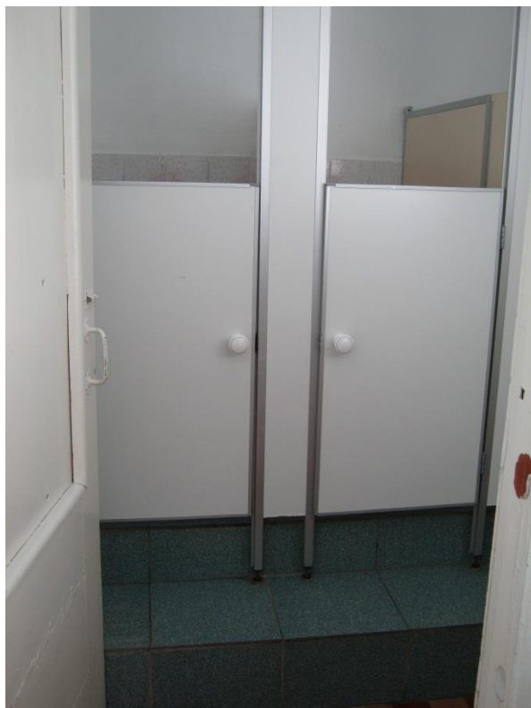
Фото № 1. Туалетная комната
