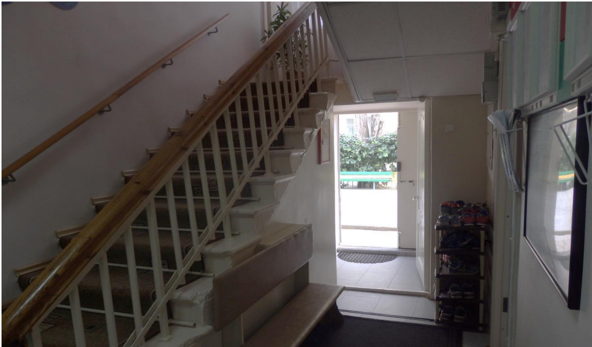
Фото № 5. Пути эвакуации (в т.ч. зоны безопасности)
