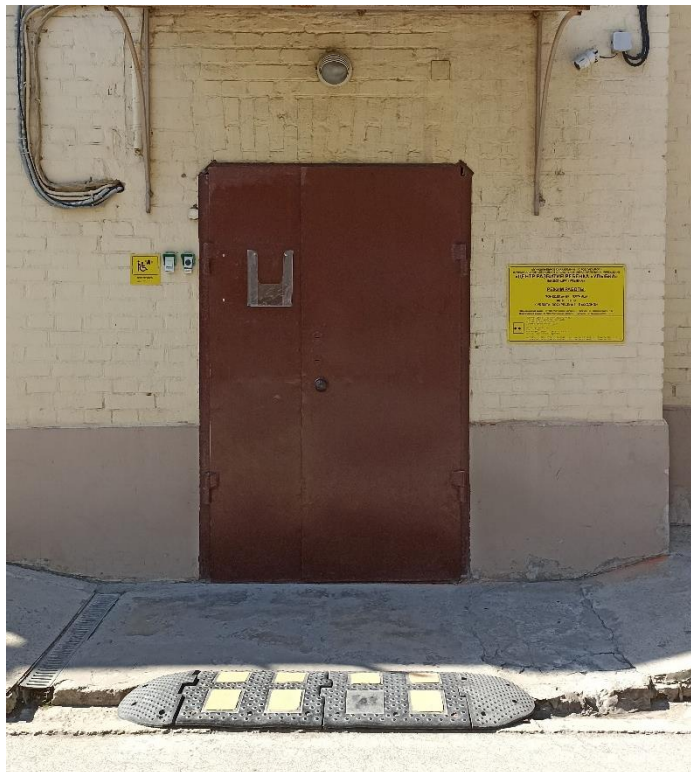
Фото №1. Входная площадка (перед дверью)
