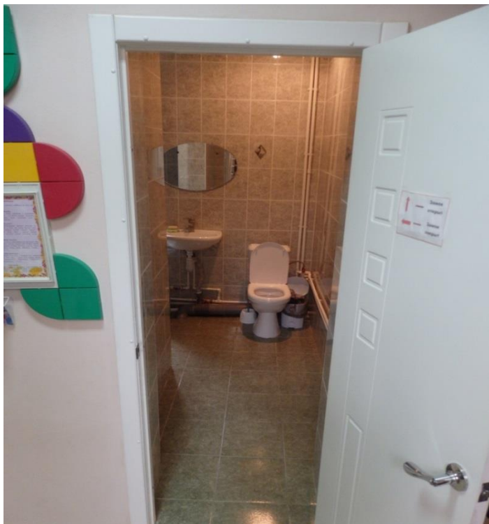
Фото № 1. Туалетная комната
