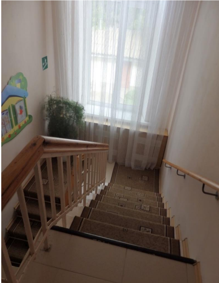
Фото №3. Лестница (внутри здания)
